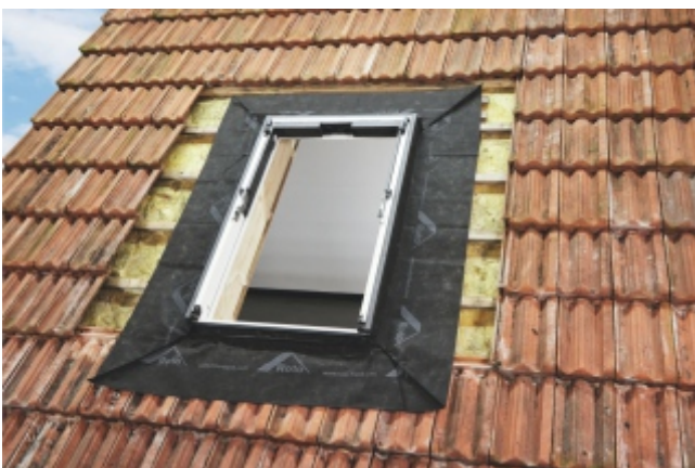
Гидроизоляционный фартук - гидро- и ветроизоляция ASA
